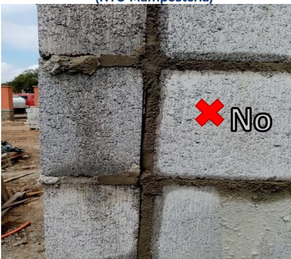
**Junteo vertical en esquinas con el riesgo de aparición de fisuras**
