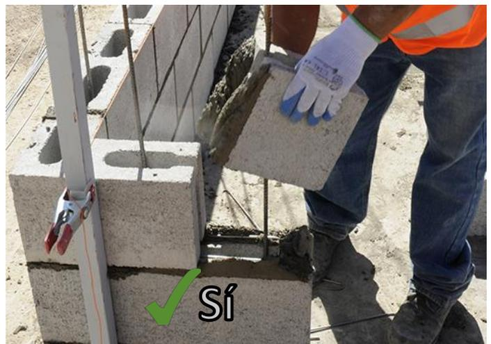
**Pieza esquinera elimina la junta vertical y permite el cuatrapeo de las juntas**
